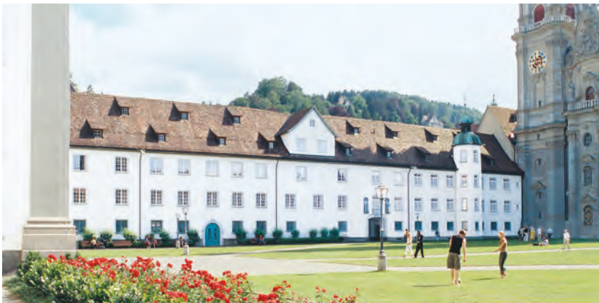
Der Hofflügel im Stiftsbezirk St.Gallen. Geplant von den Misoxer Baumeistern Giulio Barbieri und Giovanni Serro, ausgeführt unter der Leitung von Daniel Glattburger, St.Gallen-Rotmonten.
